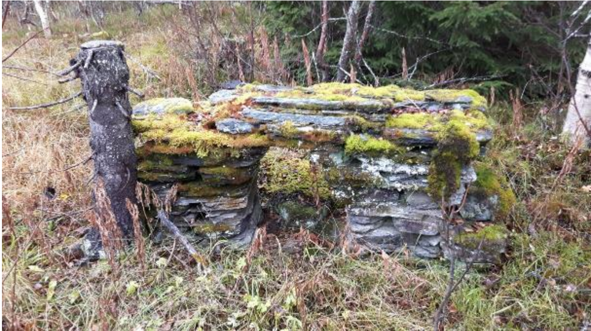
Rester etter en mur på Setervollen ved Leirbakkveien. Foto: Ottar Bergli.
