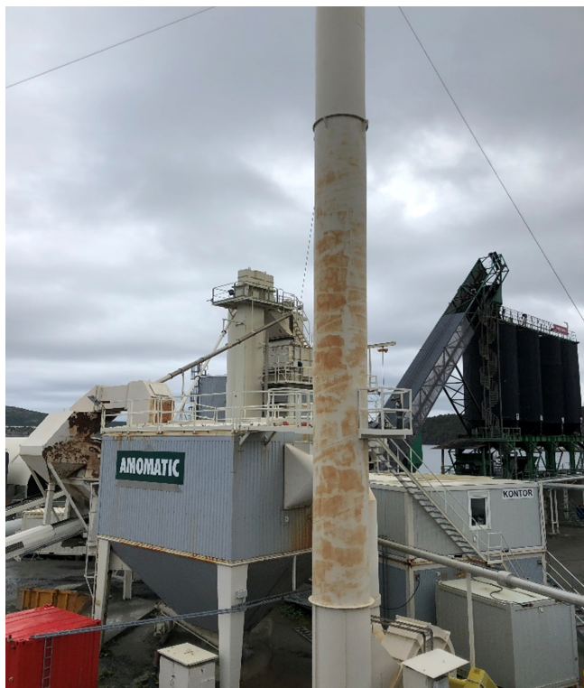
Figur 1. Prøvetaking, i kanal, skorstein.
