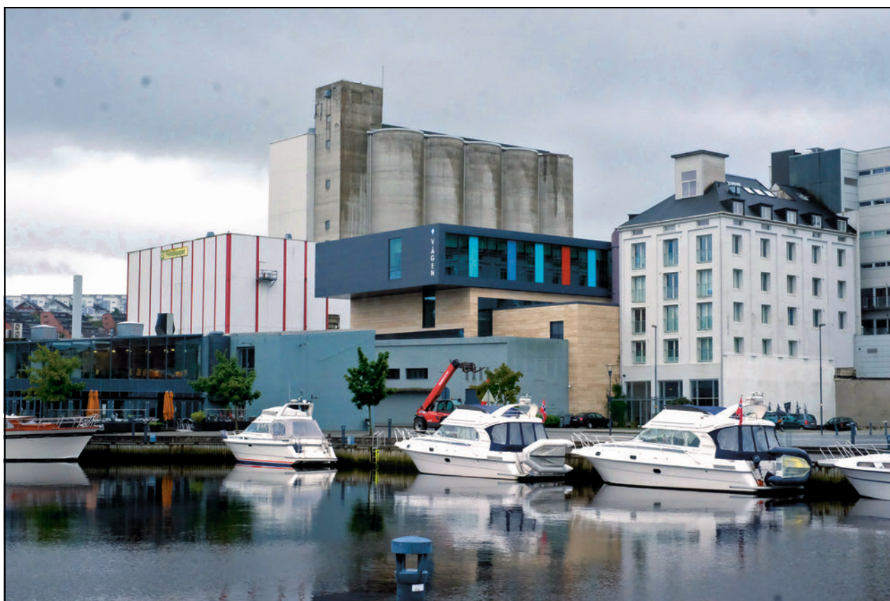
Figur 7.8 Grundige planprosessar er ein føresetnad for effektiv gjennomføring av kompliserte for- tettingsprosjekt. Sandnes.
