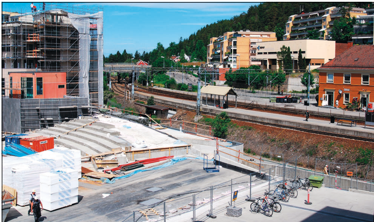
Figur 4.1 Fortetting ved Kolbotn jernbanestasjon.
