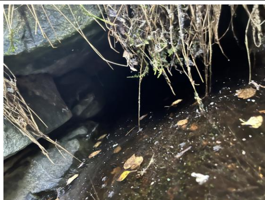
Bilde 11. Steinlagt kanal.
