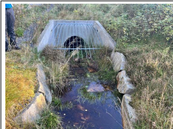
Bilde 12. Bekk kommer ut fra betongkulvert med vingemur og rist.
