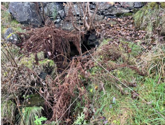
Bilde 3. Bekken går under kulvert mellom Elfiskestasjon 1 og 2.
