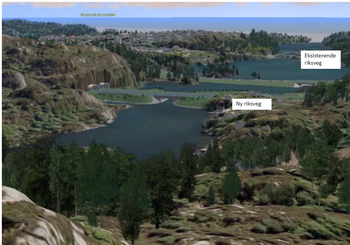
Figur 4 - Skissemodell av ny veg på fylling med kulvert over Arefjordpollen (fremst) og eksisterende riksveg (bak) [7].
