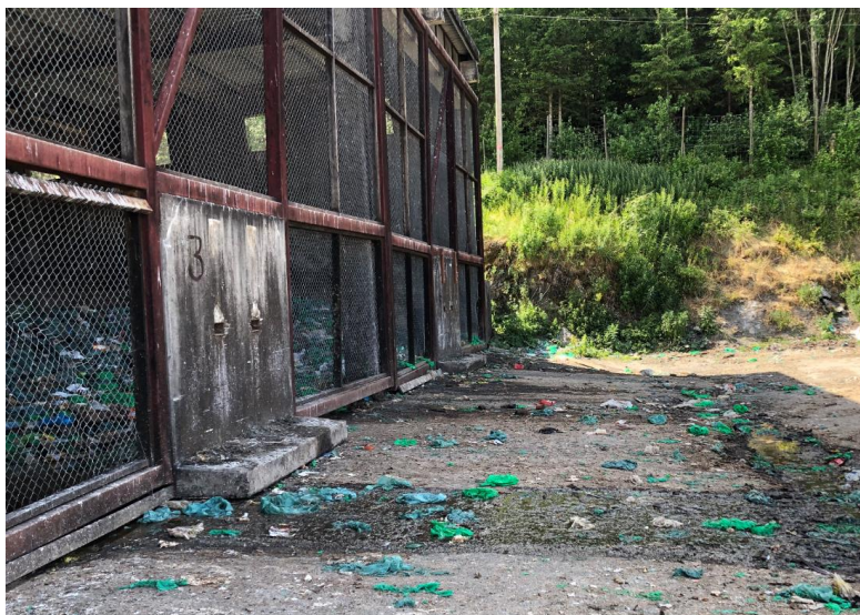
Figur 6-1: Bygg for mellomlagring av våtorganisk avfall, bilde tatt på befaring
