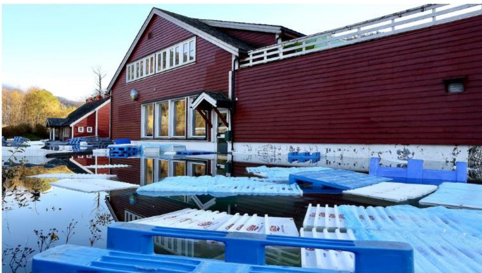
FLAUM: Flaum i oktober 2018 gjorde stor skade på fabrikk. FOTO: KJELL JØRAN HANSEN / NRK
