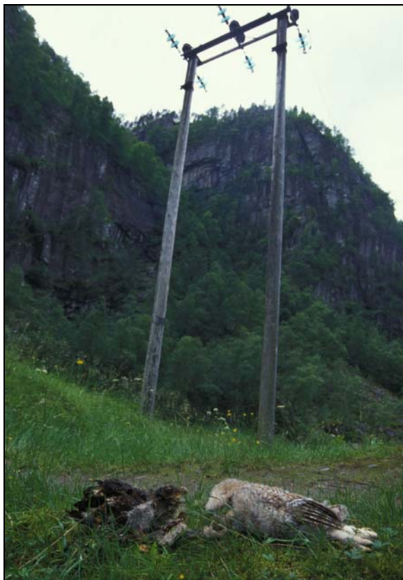
Mange fuglar misser livet ved kollisjon med kraftlinjer. Her har to kattugleungar mist livet ved elektrokusjon. Korleis kraftlinjene blir plasserte kan ha avgjerande betydning for kor stort kollisjonsproblemet blir. Foto: Sveinung Klyve.
