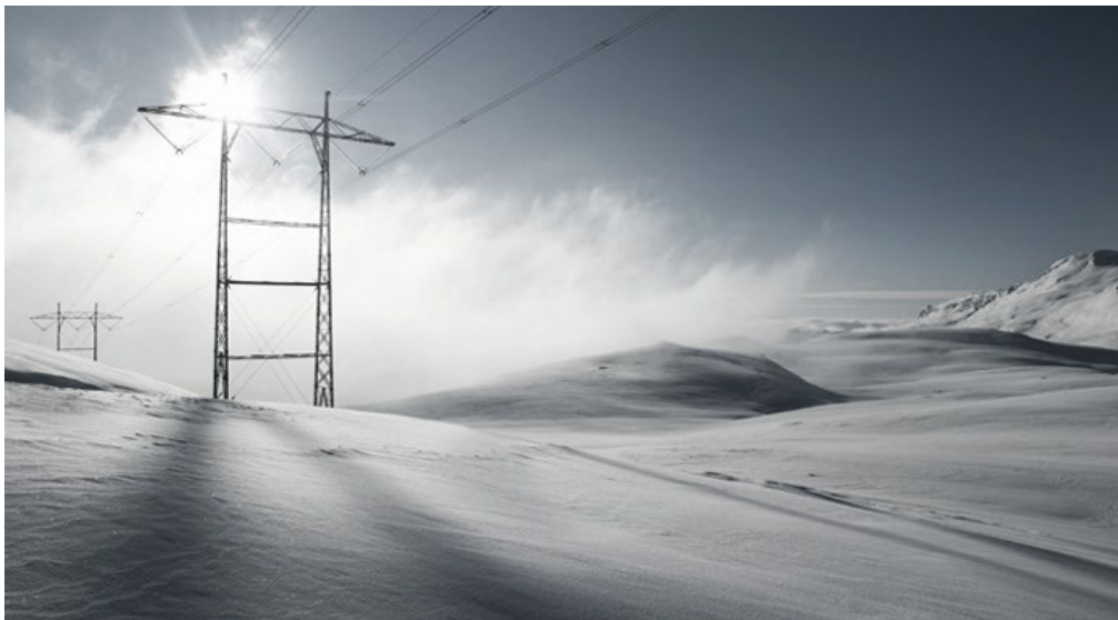
Kraftliner utsett for ver og vind. Foto: Statnett.no
