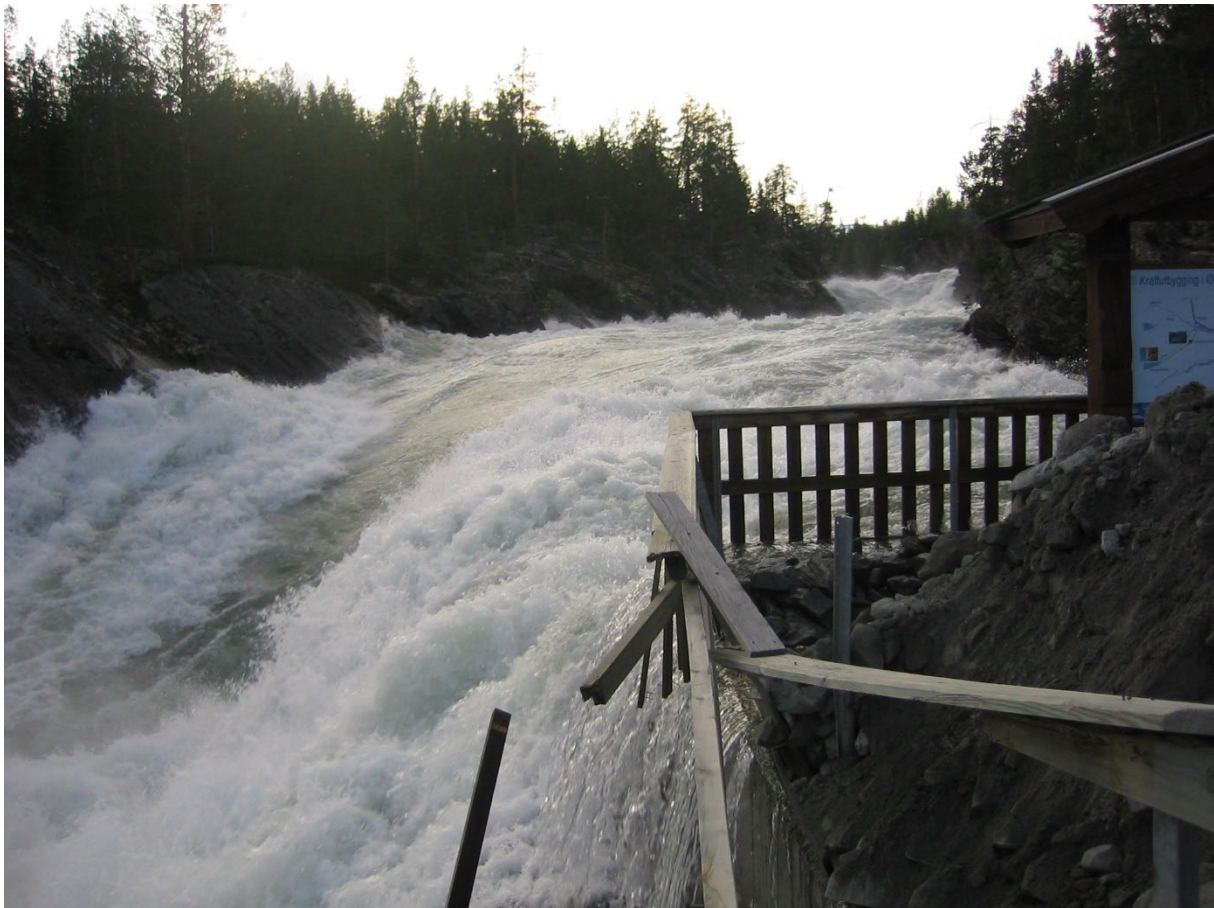
Flaumstor elv. Foto: Statsforvaltaren i Møre og Romsdal
