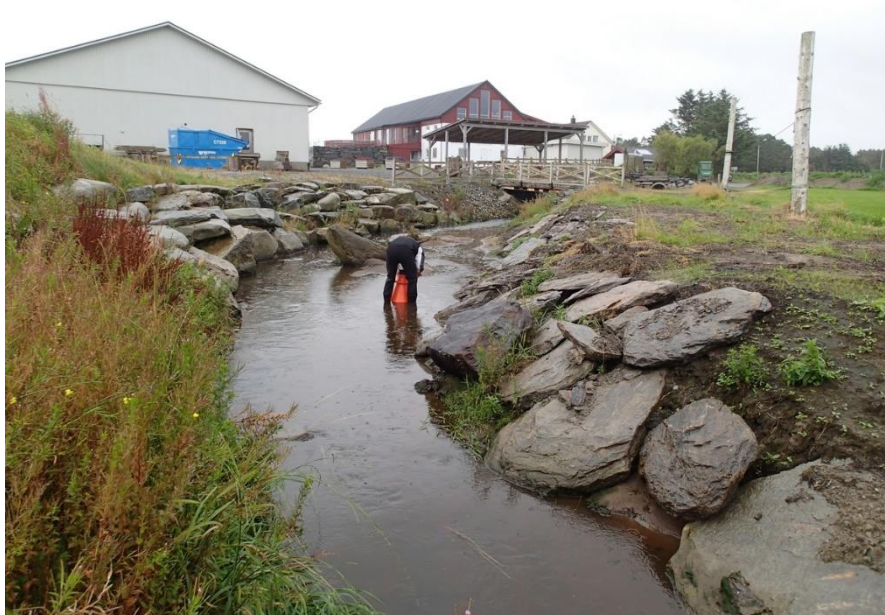
Figur 5. Oversiktsbilde fra stasjonen HES.
