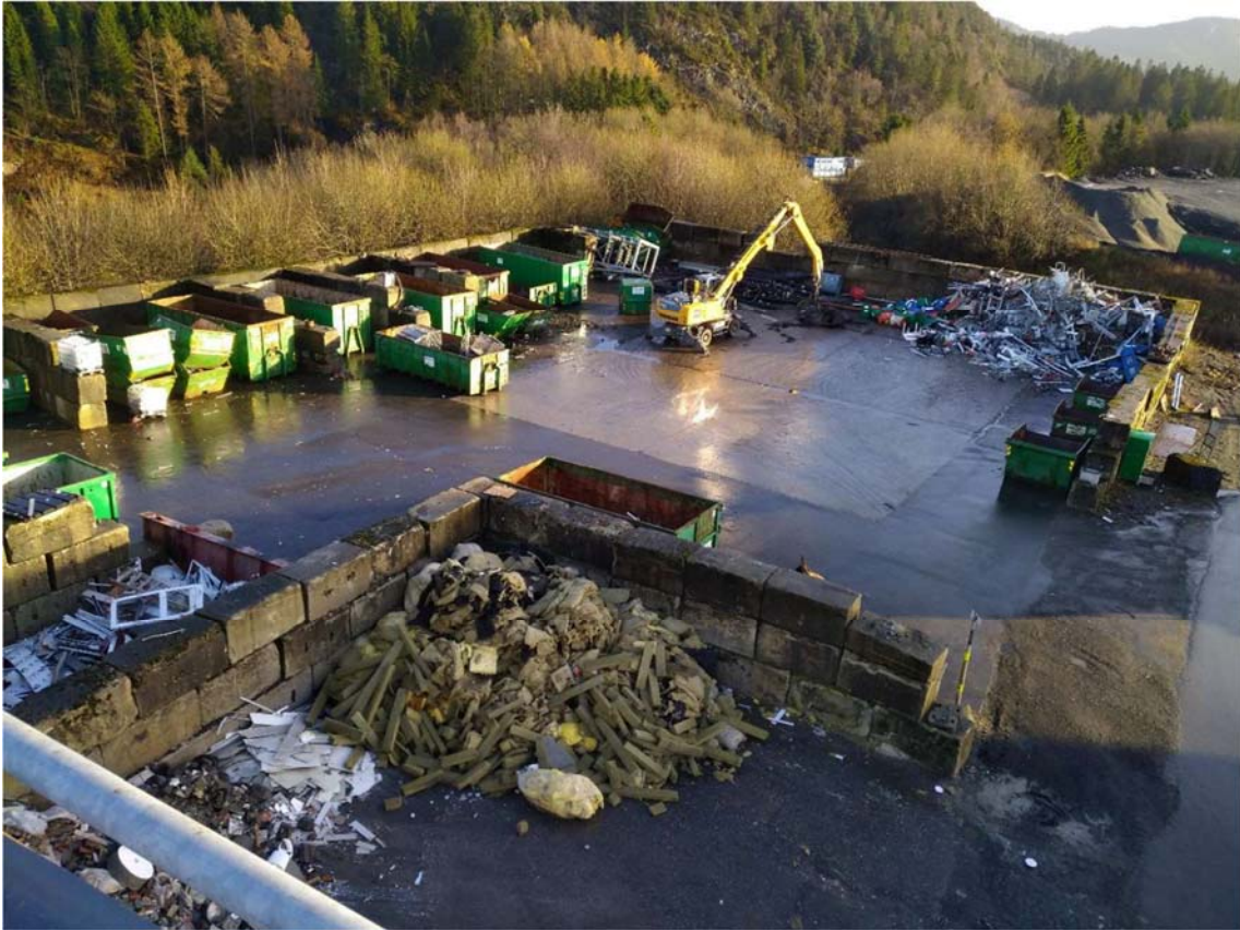
Figur 2: Bilde av tiltaksområdet sett mot sørøst. Dekket er av asfalt og betong, og området benyttes til oppbevaring av containere og diverse metallskrap. Mottatt fra Fana Stein & Gjenvinning AS.
