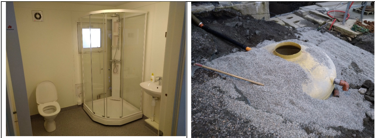
Figur 3: Viser tilfredsstillende dusj/wc/garderobe til venstre og lukket septiktank til høyre.
