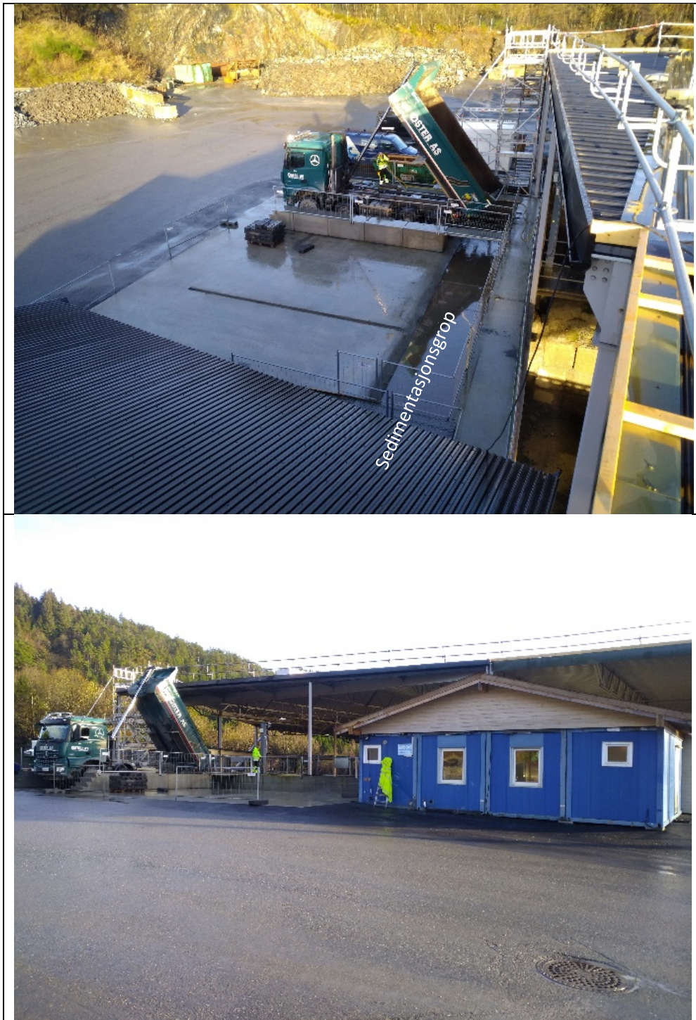
Figur 5: Spyle- og vaskeplass med sedimentasjonsgrop (øverst) og brakke med spyle- og vaskeplass.
