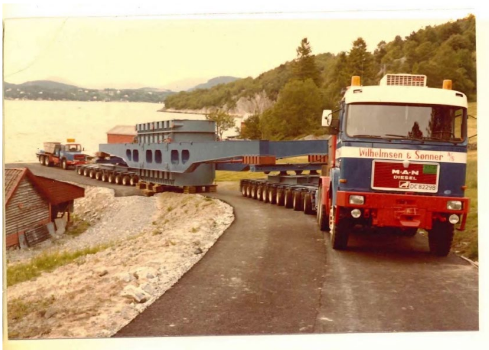
Figur 3 Kaihakk ble etablert i 1982. Bildet over er fra transformatortransport i 1982.
