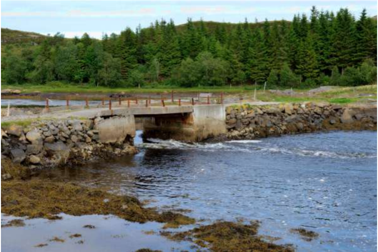
Fig. 9 Fylling og bru over Vågen påvirker vannutskiftinga (foto: Asbjørn Børset)
