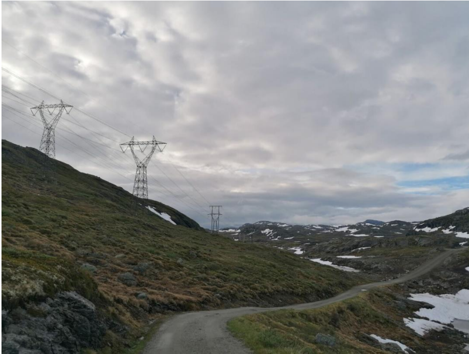
Master og anleggsvegar ved Geiterygghytta. Fjellet er prega av kraftutbygging. Dei fleste vegane er opne for allmenn ferdsel og vert nytta av kraftselskapa, beitenæringa og turistar. Foto Inger Marie Hernes, SFVL.
