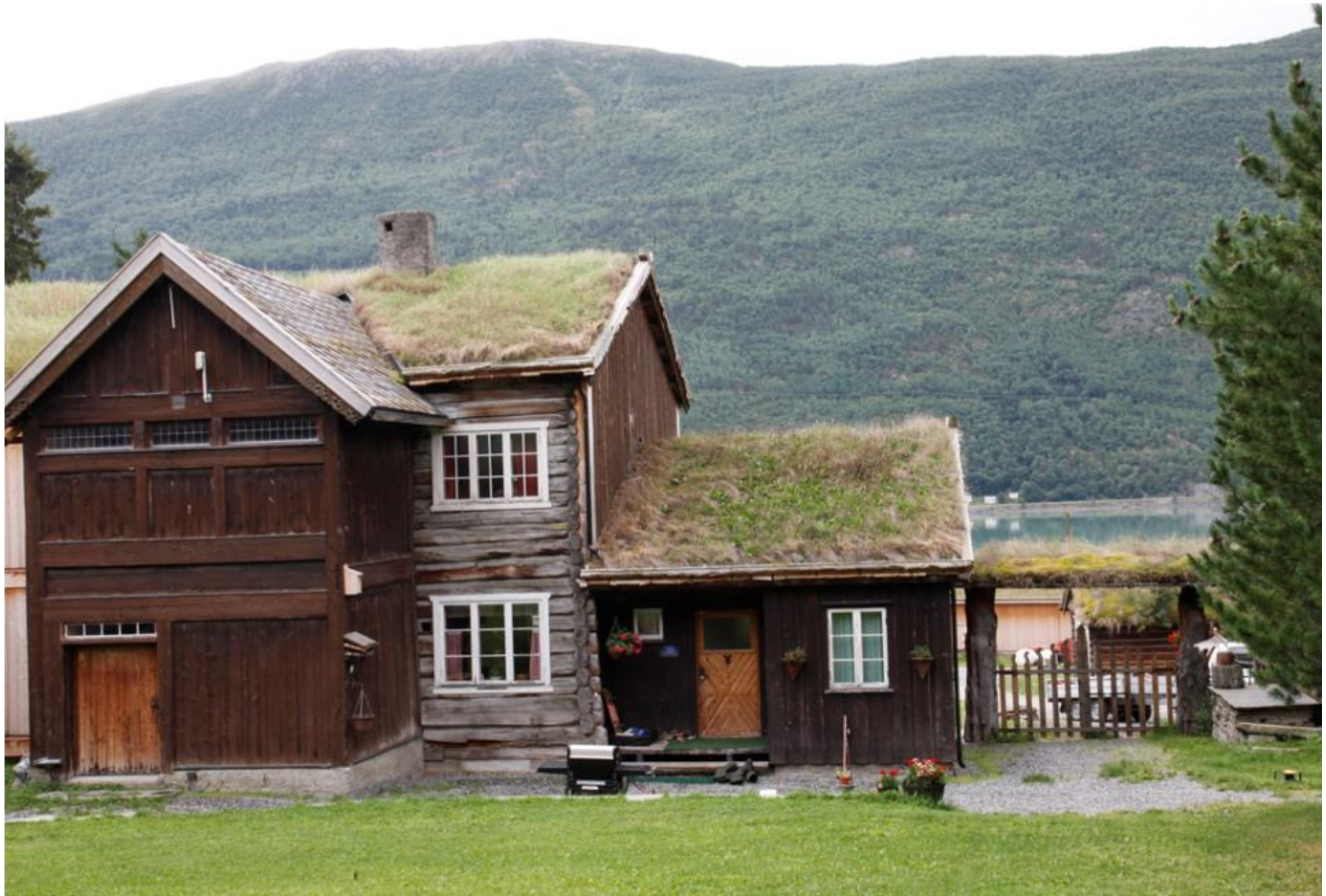
2014. Sygard Valde i Nordherad. Vågå / Oppland. Våningshus fått tilbygg og stabbur flyttet.
