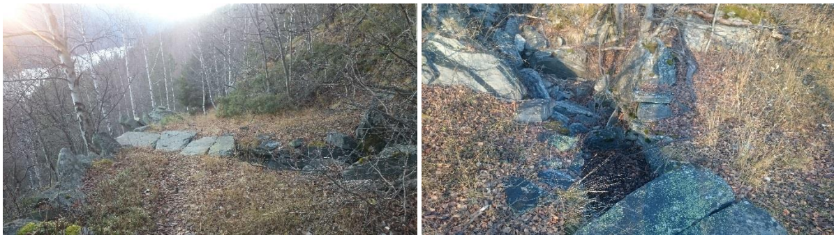
Turstigen nord for Grevrusten og Kleivi går etter ein forseggjort ferdseisveg, som både har stabbesteinar, klopp og pent mura stikkrenne. Foto: Kjersti Tidemansen.
