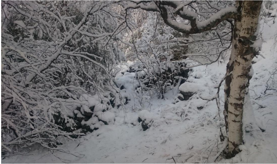
Restar etter mur i Kattholet. Foto: Kjersti Tidemansen.
