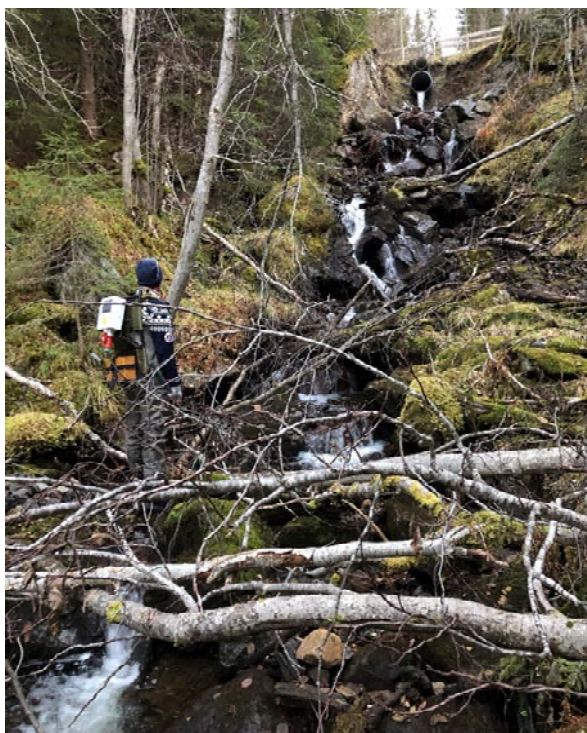
Figur 33 Kort og bratt bekk. De to kulvertrørene sees øverst i bildet.
