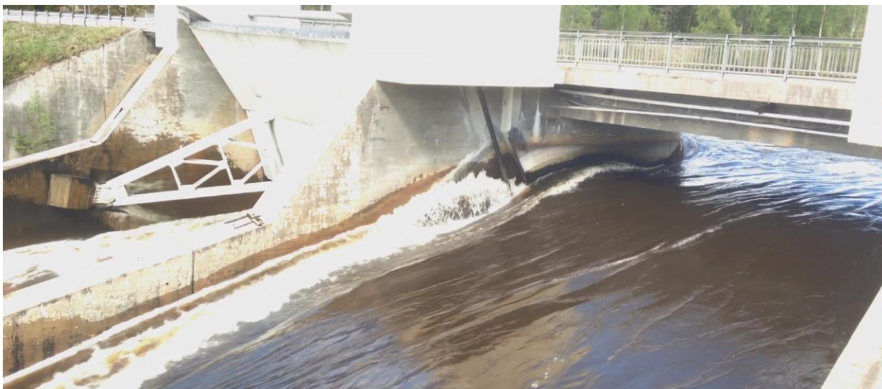
Figur 15. Spillvann sluppet som overflatevann gjennom sektorluke ved Lutufallet kraftverk. Det er antatt at utvandrende fisk i stor grad vil følge dette løpet ved vannslipp her.
