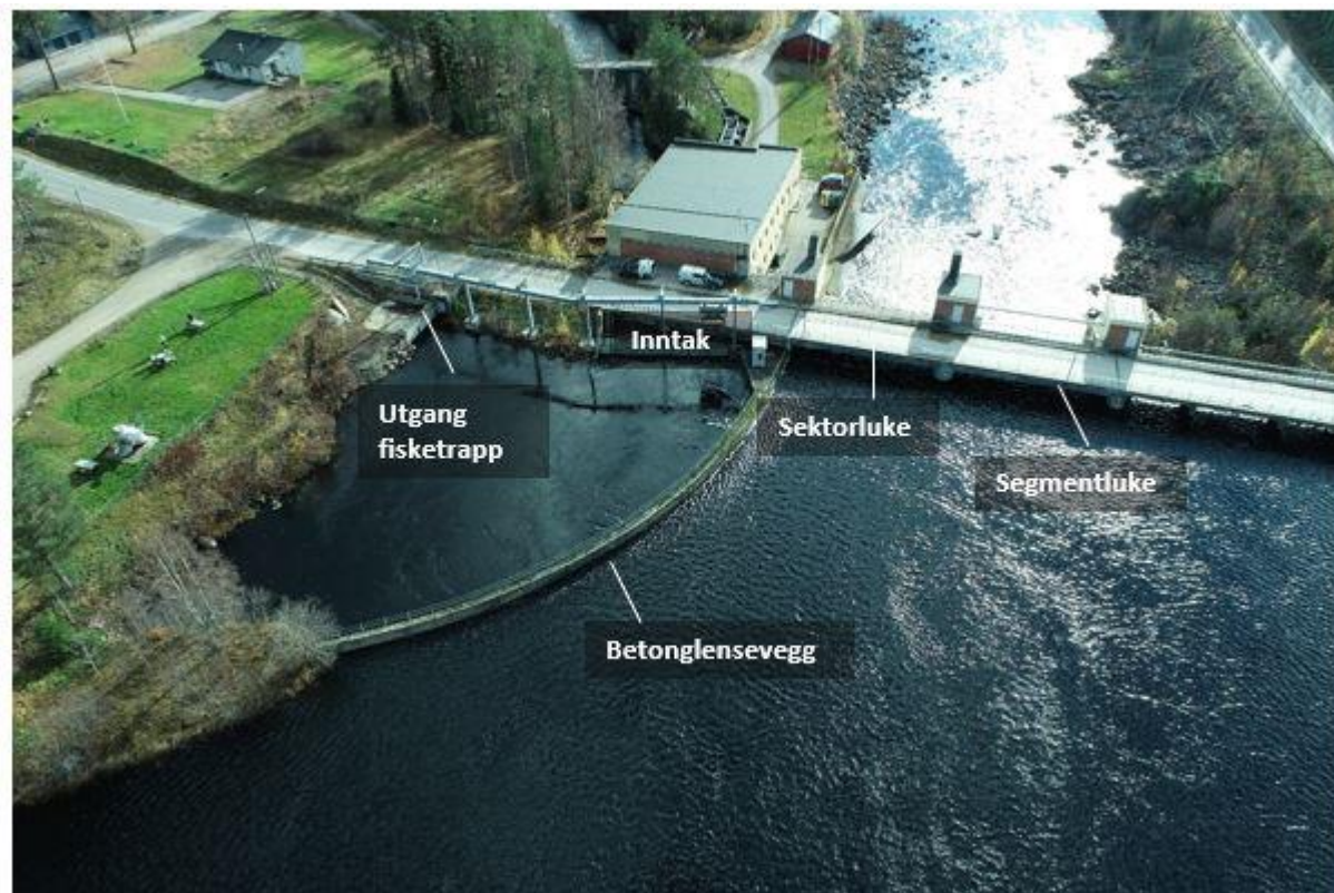
Figur 17. Oversiktsfoto av inntaksområdet til Lutufallet kraftverk. Foto: Norconsult AS.
