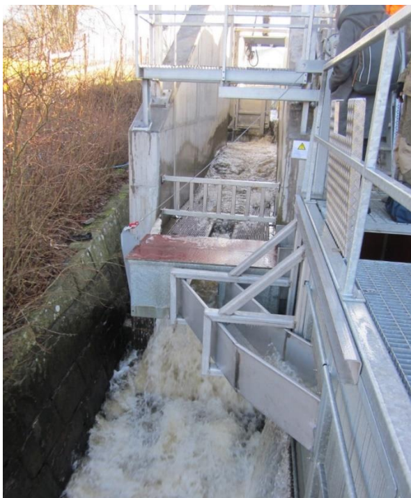
Figur 13. Finnist i fiskeavlederen ved Herting kraftverk i Ätran. Formålet med rista er å skille ut nedvandrende fisk fra vannet, ved at fisken sklir oppå rista ned i en oppsamlingsrenne som føres til et oppsamlingsbasseng. Foto: Norconsult Sverige.
