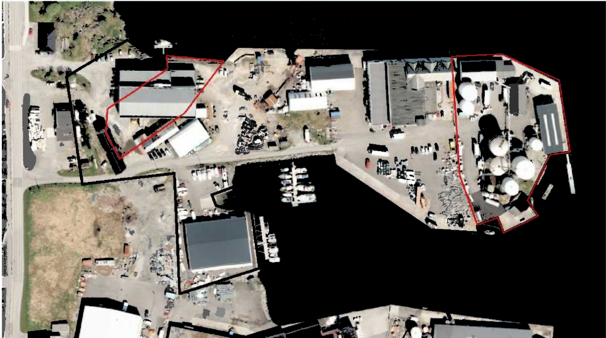
Figur 5-3 Dagens situasjon med eiendomsgrenser. Drønnes mekaniske nedbygde slipp er merket med rødt omriss til venstre i bildet, mens Mørebunkers sine arealer er markert med rødt til høyre i bildet.
