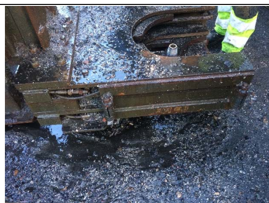
Oppspylte masser Br6.
