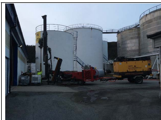
Boring av Br6
