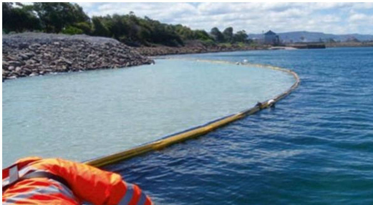
Figur 21: Siltgardin montert for å hindre spredning av partikler ved utfylling fra land (fra Aussie Products).
