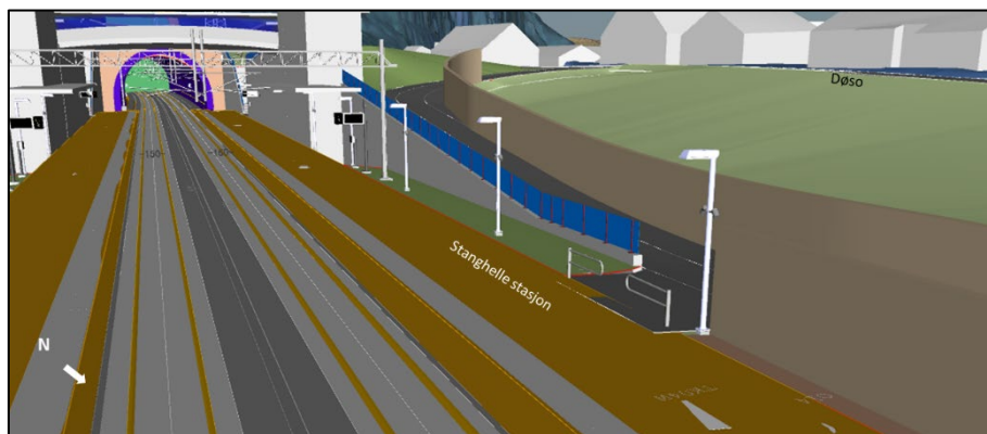
Figur 5–84: Bedehustomta på Stanghelle etter byggefasen, midlertidig park med støyskjerming mellom spor og eksisterande bygningar.
