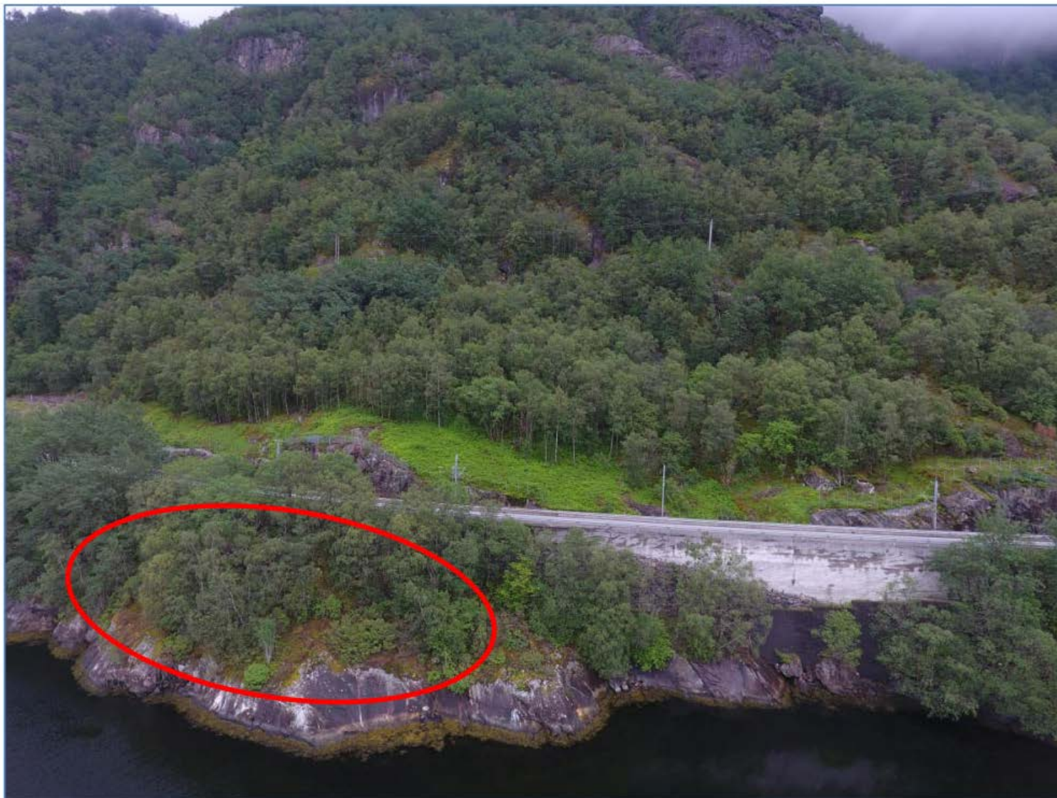
Figur 27. Dronebilde av Svabakken og terrenget over påhugget. Området for påhugget er vist med rød ellipse.
