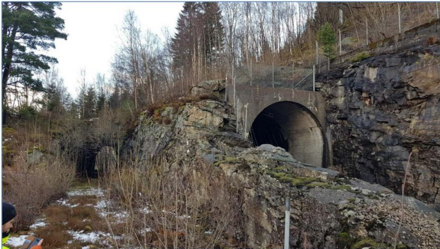
Figur 15. Bilde av tunnelene ved Linnebakkane. Eksisterende Lille Fossmark II ses til høyre og tunnellopet for den utrangerte tunnelen til venstre.
