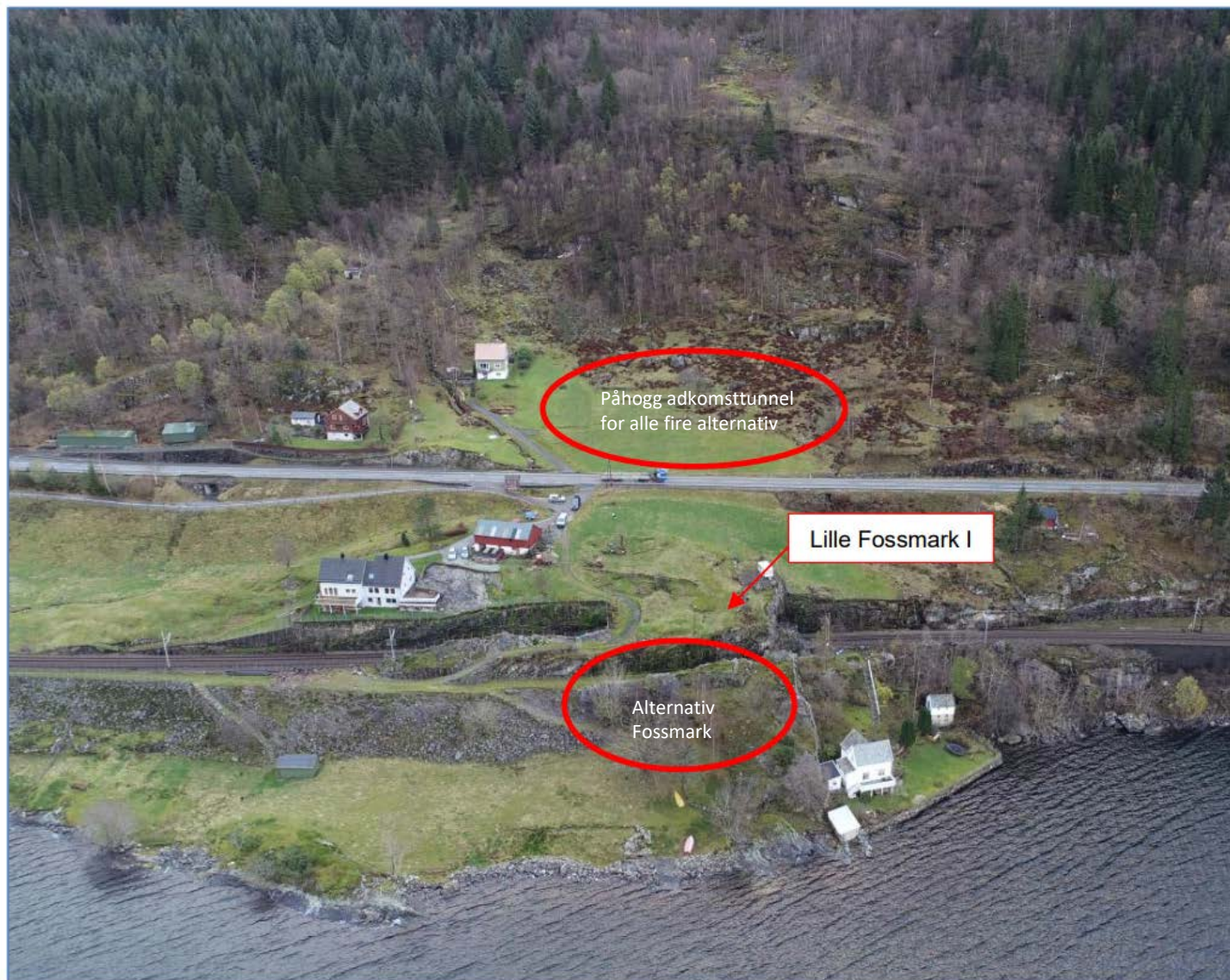
Figur 8. Dronebilde fra Fossmark, med avmerking av områdene for påhogg ved Tongneset (nede) og ved E16 (oppe). Eksisterende banetunnel Lille Fossmark I ligger like ved påhogg Tongneset.
