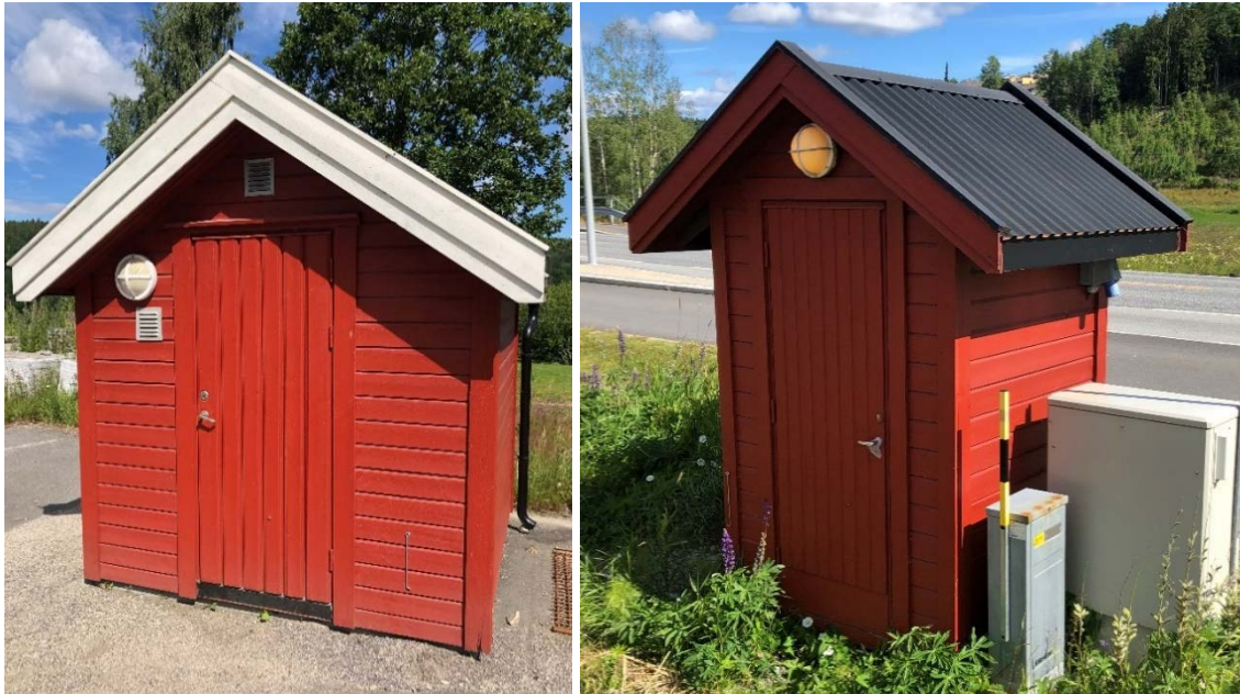
Figur 21 Overbygg pumpestasjon 2,4 x 2,4 meter (til venstre) og 1,2 x 1,2 meter
