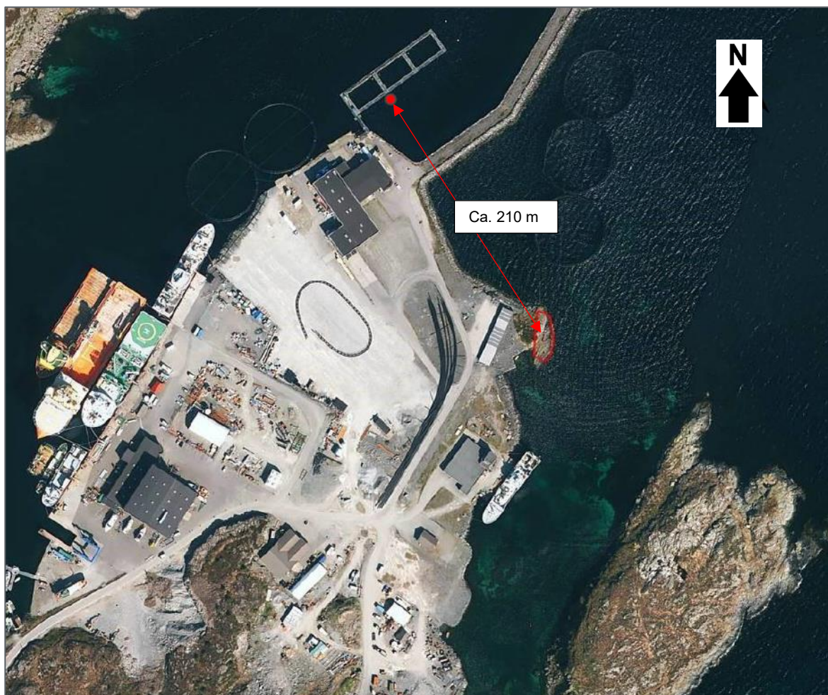
Figur 7. Området hvor det ble gjennomført prøvesprengning er illustrert med rød ellipse. Hydrofonens plassering er vist med rød sirkel. Avstanden i luftlinje er ca. 210 m.
