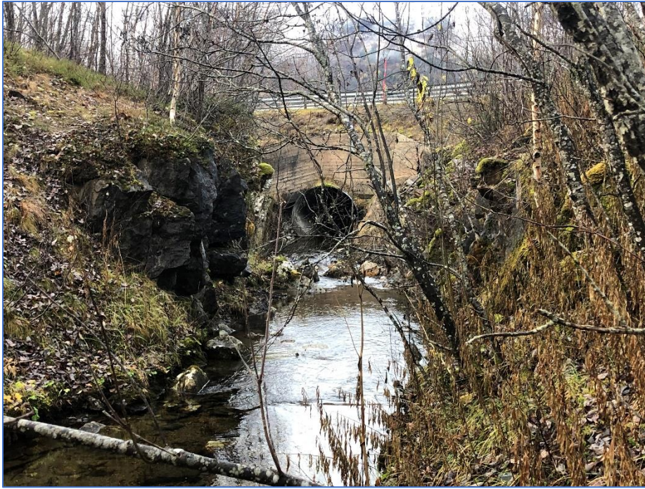
Figur 7 Kanal som leder Merrelva under dagens E6
