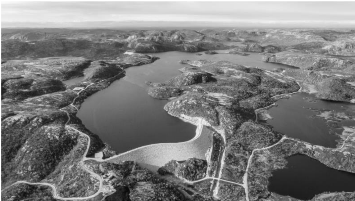
Oversiktsbilde av det nye Nåvatn-Skjerkevatnmagasinet. Kilde: AEVK
