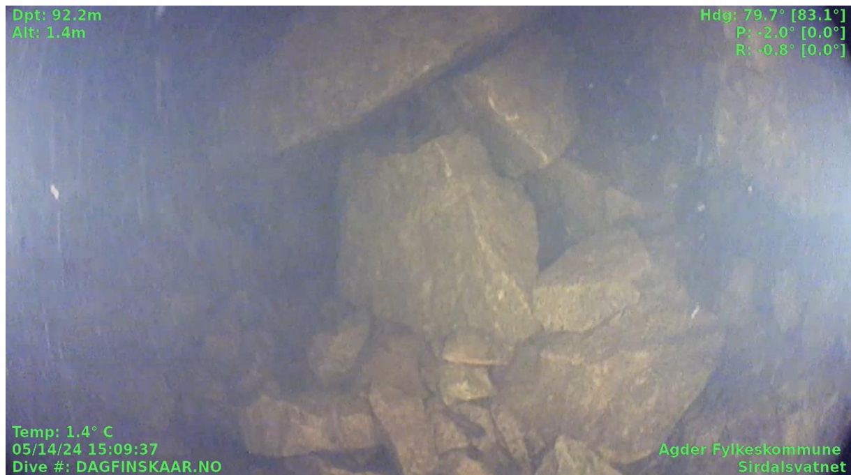
Figur 5. Eksisterende steinfylling
