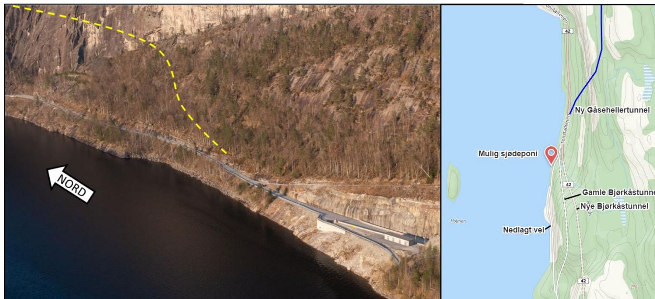
Figur 3 Nordenden av Bjørkåstunnelen med stipling som markerer omtrentlig trasé for ny Gåsehelltunnel. Tipping av stein ut i Sirdalsvannet kan være aktuelt langs vannkanten vi ser på bildet. Foto 14.09.23 Agder FK
