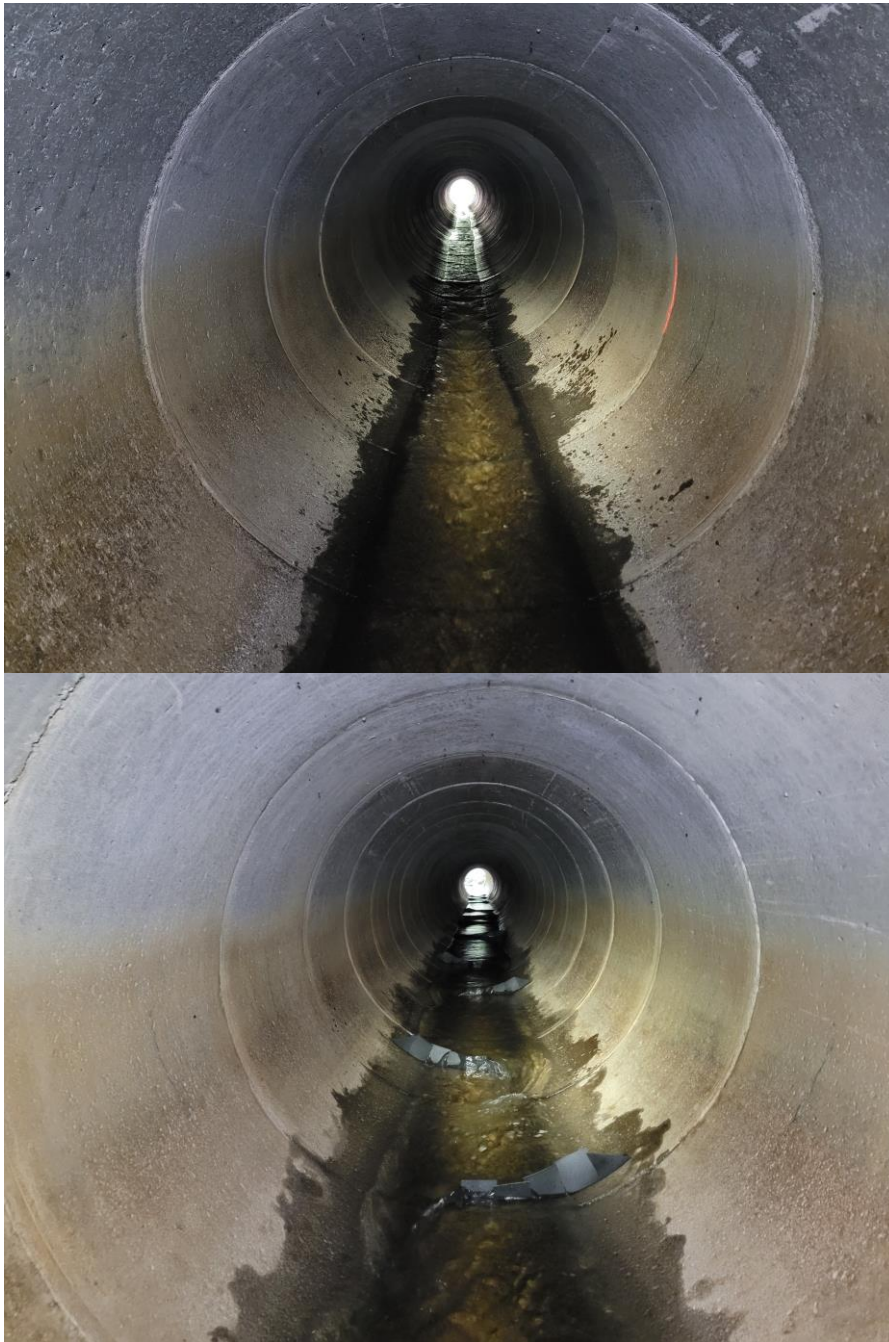
Figur 11: Fleksiterskler montert i Remmenbekken i Halden. Kulverten er 2000 mm og bekken er anadrom med sjøørret. Før montering klarte ikke fisk å passere kluverten pga. for bratt fall med lite vann. Etter montering bremses vannet opp og det dannes en fisketrapp inne i kulverten.
