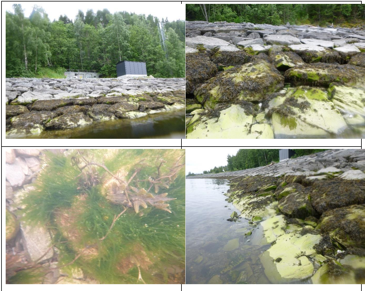
Figur 9: Naturmangfold på fylling ved transformatorstasjon sør på Hellstranda. Øverst t.v: Oversiktsbilde. Øverst t.h. Fucus sp. og trådformete grønnalger. Nederst t.v. Fucus sp. og trådformete grønnalger i sjøen nedenfor fyllingen. Nederst t.h.: Oversiktsbilde.
