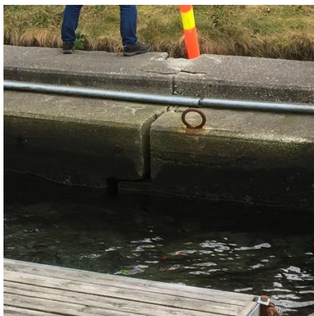
Bilde som viser åpning i fronten og knusning i bakre del av skjøten
