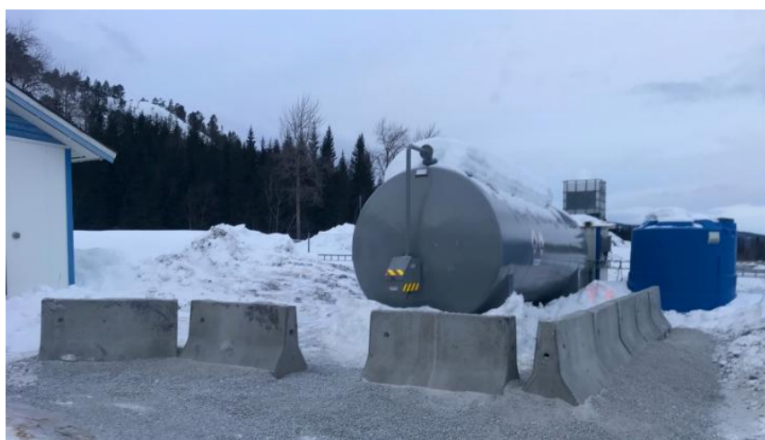
Figur 6 viser diesel tank (30 m 3 ) på Forbergskog
