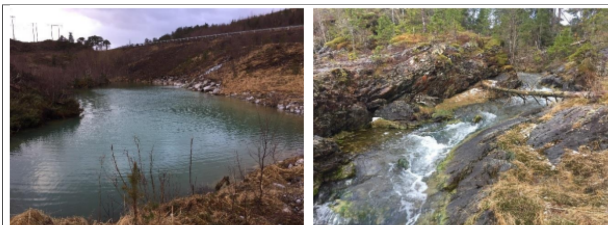
Figur 13 viser sedimentasjonsdammene før utslipp til Sørfjorden samt bekken ut. Vannet til Sørfjorden er en blanding av overflatevann fra veg og fra sedimentasjonsbasseng
