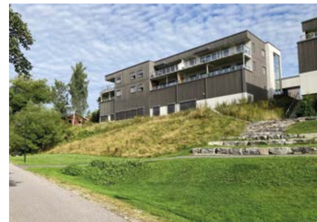
Evjudalen. Muligheter for dyrking på vegg og i skråning Foto: Laurie Vestøl
