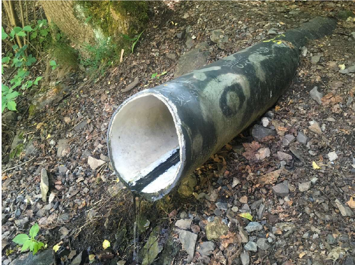
Figur 20. Flere rør for blant annet overvann kommer ut langs elva. Dette er en potensiell forurensningskilde. Foto: Maria Hertzberg.
