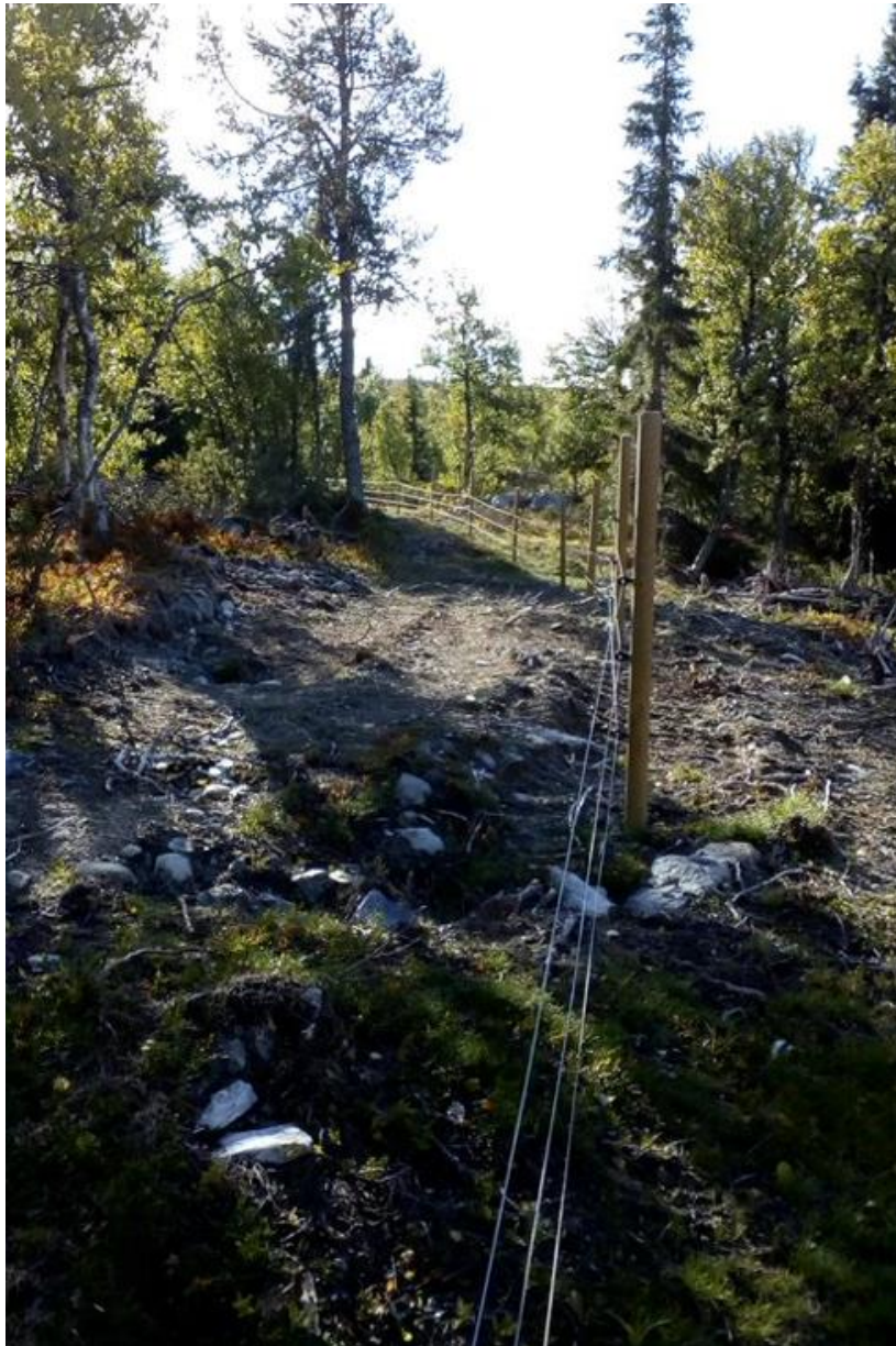
Figur 2: Trase ryddet med gravemaskin for å fjerne brisk og gi tilkomst med ATV
