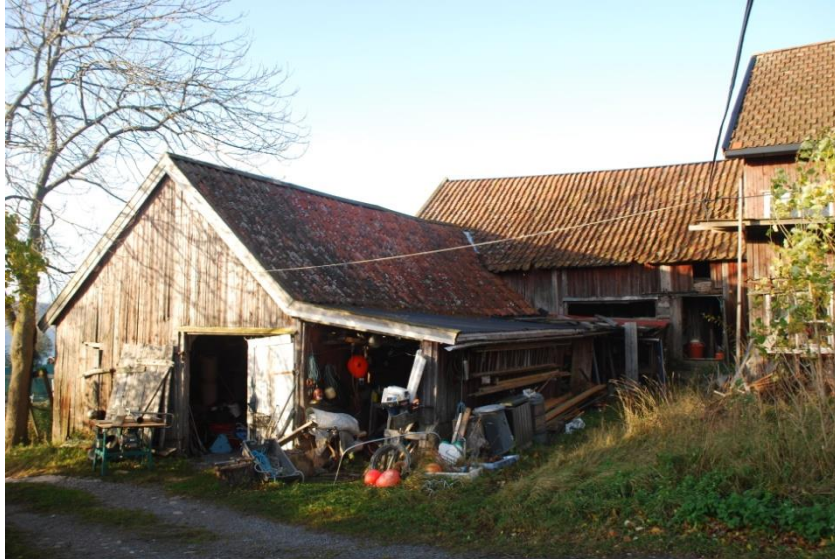
Driftsbygningene på Hasselgården har stor grad av historisk dybde og særpreg, og er under restaurering.
