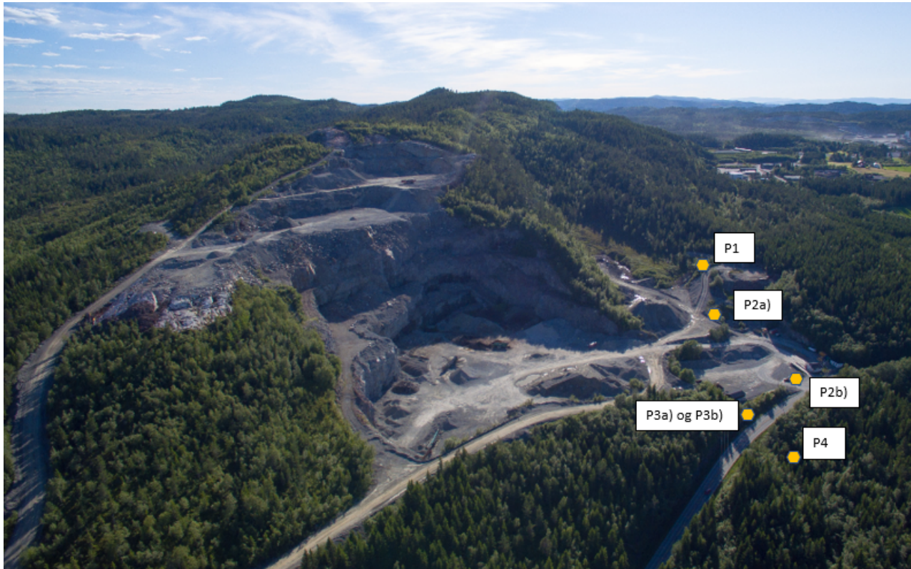
Figur 2: Målepunkter for overvåkning av overflatevann
