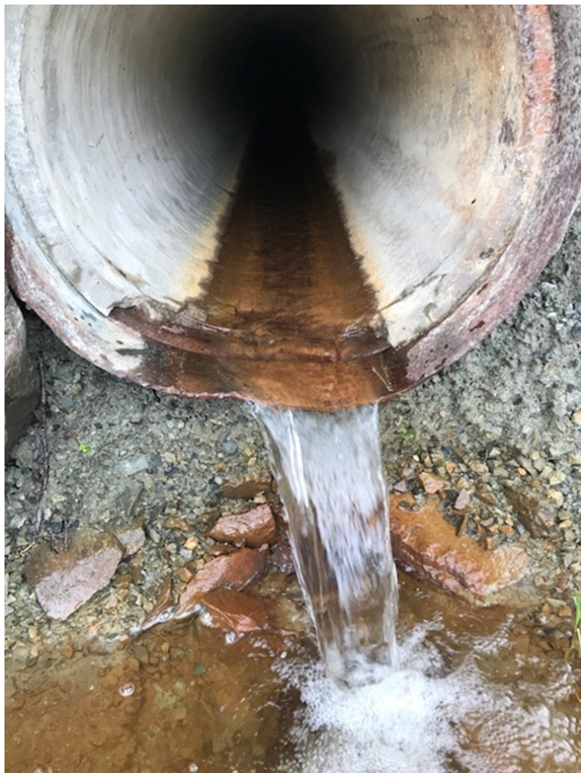
Figur 3: P2a) Vann ut fra massetipp
