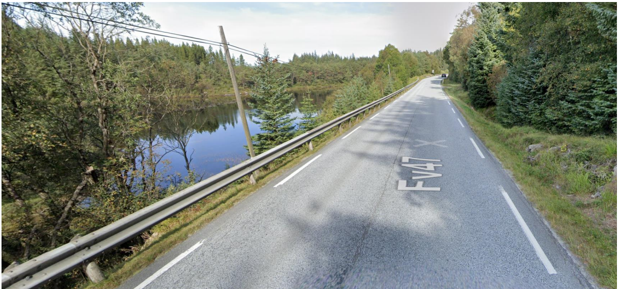
Figur 4 Fylkesvei 47 mot nord med Rovatnet på venstre side. Rovatnet drenerer til Forevatnet.
