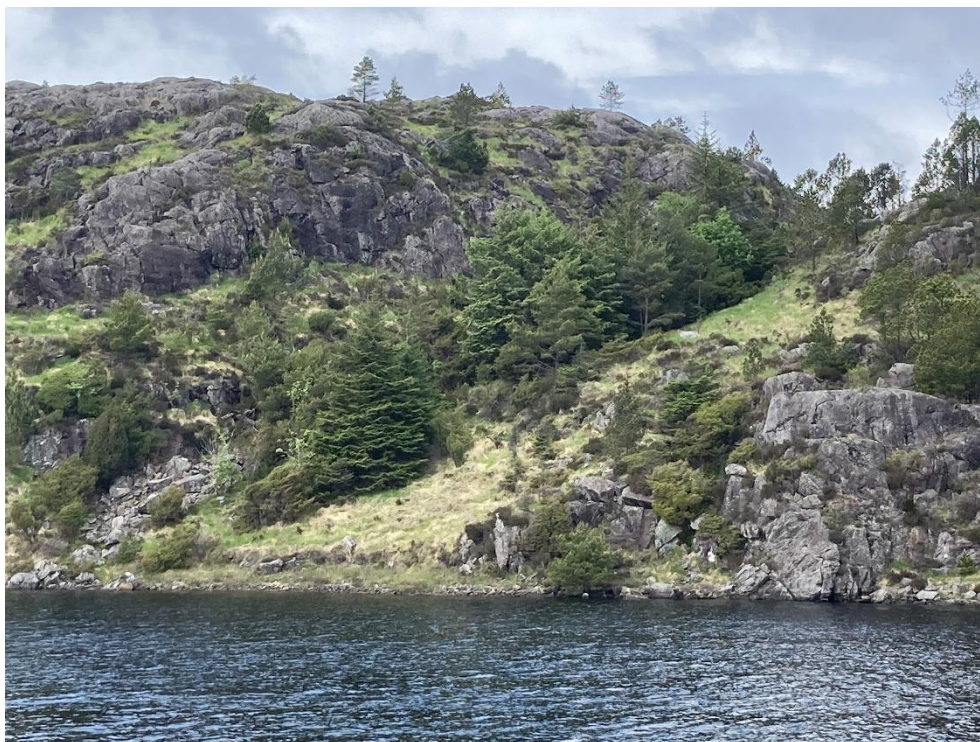
Figur 23 Landtak for reintvannsledning på nordsida av Forevatnet
