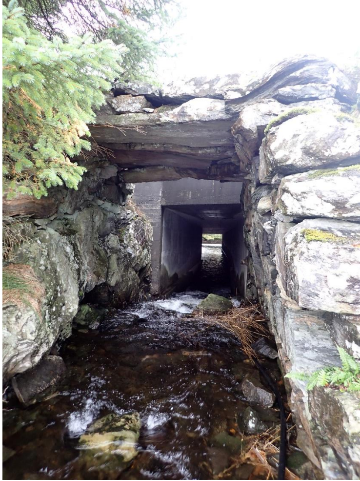
Figur 14 Utløpet av Forevatnet under fv 47
