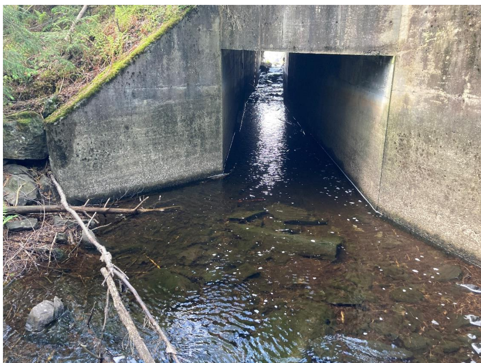
Figur 16 Kulvert under fv 47 sett nedenfra
