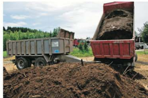
Kontroll av jord ved mottak må gjennomføres for å sikre at jorda leveres i henhold til bestilling. Foto: Erling Fløistad.
