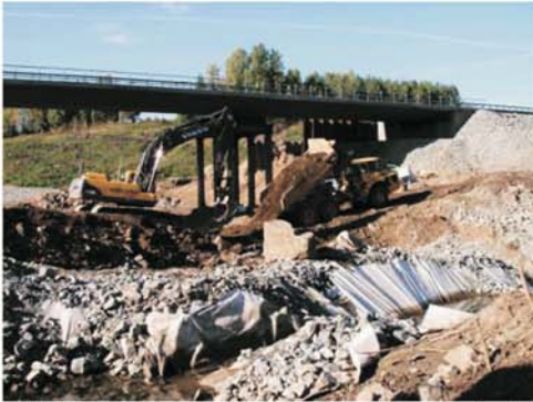
Infiserte masser kan brukes til undergrunnsjord. Ved svært problematiske ugras bør undergrunnsjorda i tillegg dekket med duk og rene masser. Foto: Tore Felin.
