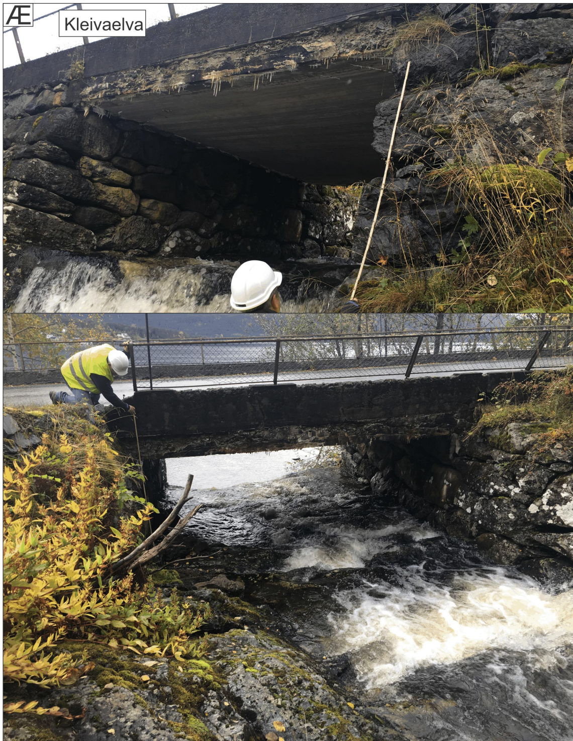
Figur 24: Den austre bruopninga til Kleivaelva er ca. 8,5-10 m 2 . Øvste biletet er teke frå nedsida av brua og nedre bilete er teke frå oppsida av brua. Elva renner på fast fjell, og det er lite lausmassar i sjølve elveløpet. Berget er relativt massivt, men ein kan sjå svake nordvest-søraustorienterte sprekker med eit bratt fall mot nordaust.
