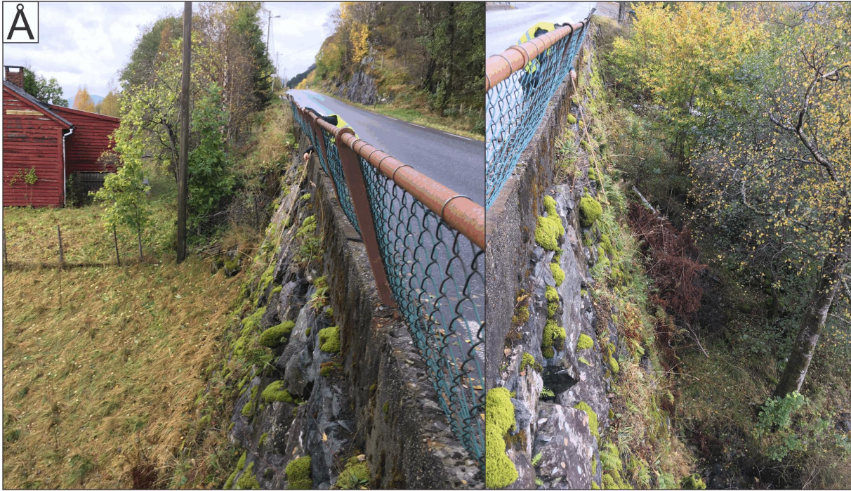
Figur 27: Muren til brua på nedsida/sørsida fortset ca. 40 m mot nordvest. Høgda på muren aukar til 7-8 m på det høgste ca. 23 m nordvest for brua.
