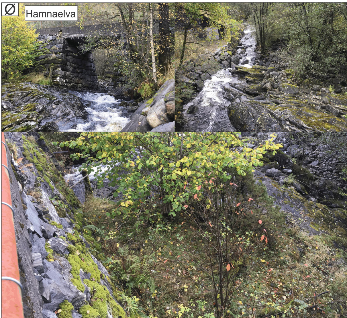
Figur 26: Bileter av Hamnaelva. Bruopninga ca. er 18-20 m 2 og elva renner også på fast fjell med stadvis lausmassar av stein og grus. Her er fjellet kraftigare foliert, men det er ingen oppsprekking. Foliasjonen er orientert ca. 330° nordvest med eit fall mot sørvest.
