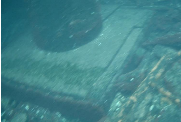
Figur 5-1: Stillbilde fra video av fundament til betong søylene til bygget ute i elven. Video/foto: IMC Diving.
