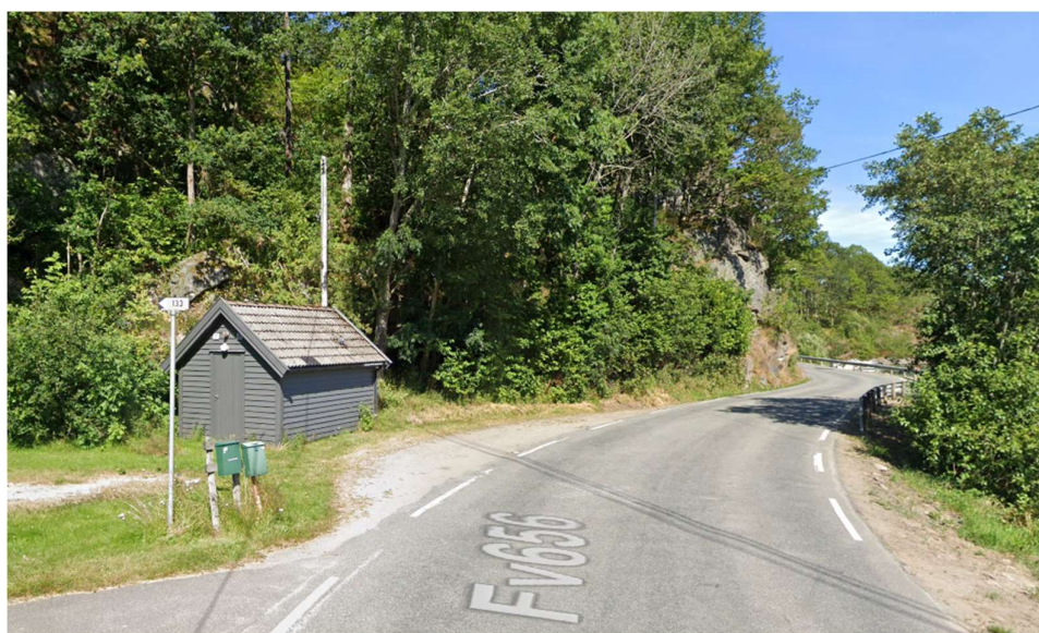
Kommunal pumpestasjon med overbygg, PA-0402 Ytre Svenevik, fra slutten av 80-tallet. Stasjonen er i dårlig stand og har behov for fornying.
