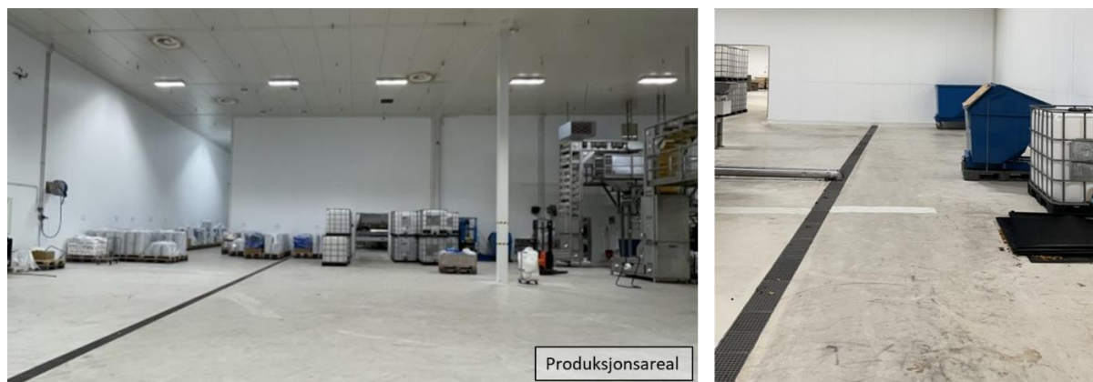
Figur 8 Deler av produksjonsareal. Vann drenerer til sluker/rist i gulvet.
