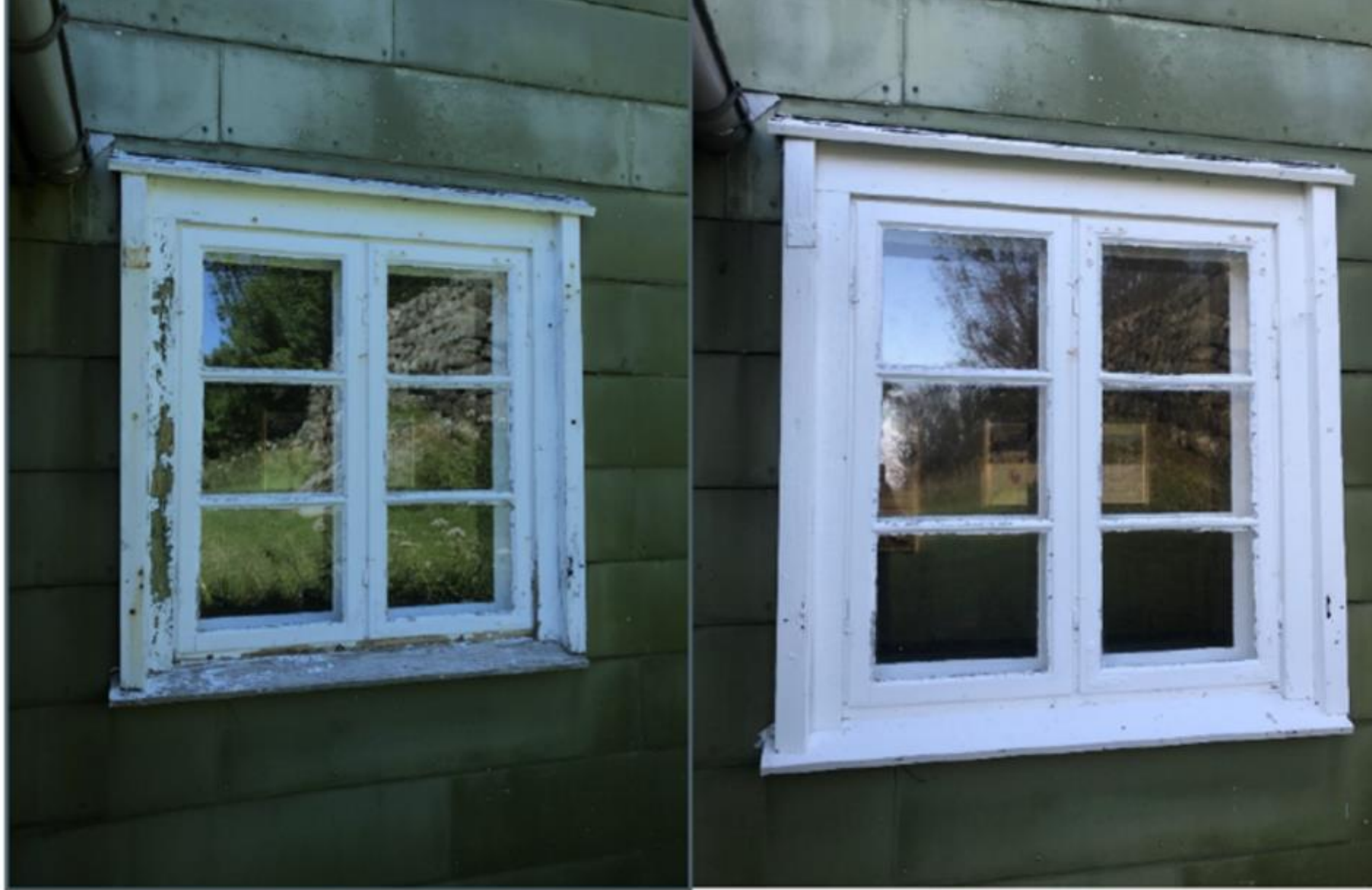
Vindu bak sidedør, før/etter.
