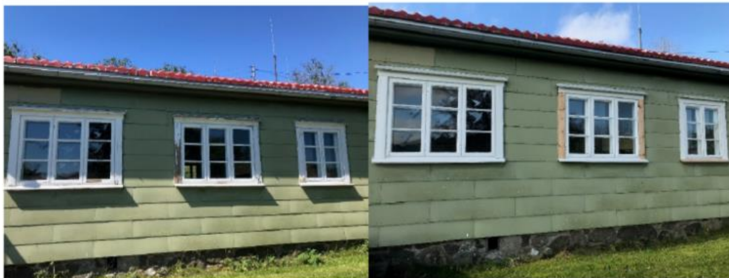
Vinduer front, før/etter. Nytt trevirke males sommeren 2019.
