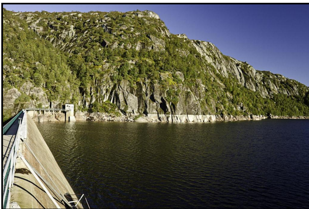
Figur 6-10. Dammen syd i Langevatn. Foto tatt 23.08.2011 av Finn Gravem.
