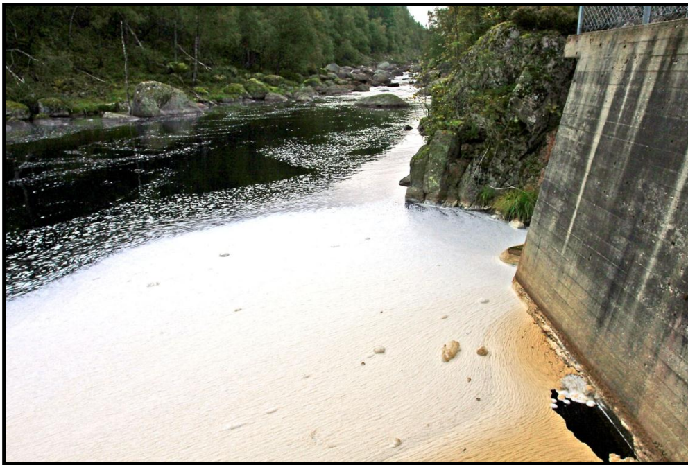
Figur 6-52. Inntaksdammen i Monn, som ligger ca 3 km nedstrøms utløpet av Bredlandsvatnet. Foto 26.08.2011 Finn Gravem.
