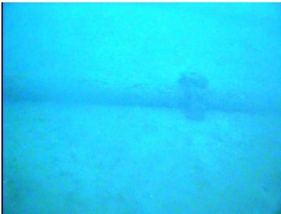
Figur 42: Rørledning på sjøbunnen ved Løkholmen (Agder Dykk AS, 2018).
