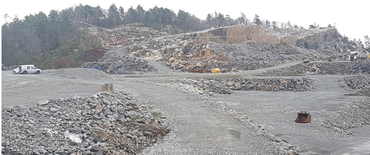
Figur 5 - Igangsatt terrengarbeid sett mot øst, vinter 2020. Rester av Kattetjønnåsen mot høyre i bildet (Foto: Multiconsult)
