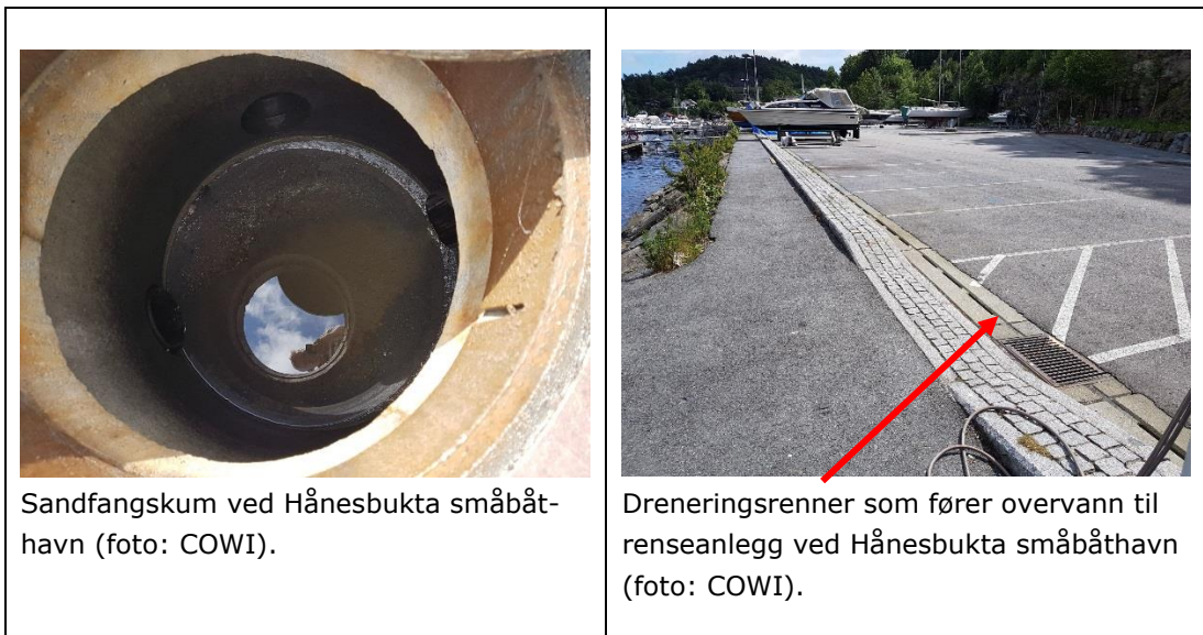
Figur 4.5: Sandfangskum og dreneringsrenner ved Hånesbukta småbåthavn.
