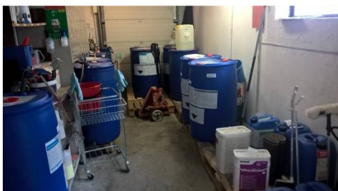
Oppbevaringsrom for vaskekjemikalier. Dør ut ses rett frem.
