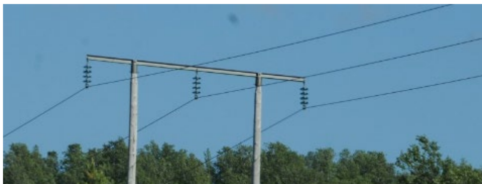
Mast med hengekjeder, liten fare for elektrokusjon. Fareklasse D. Foto: Jan E. Gunnersen
