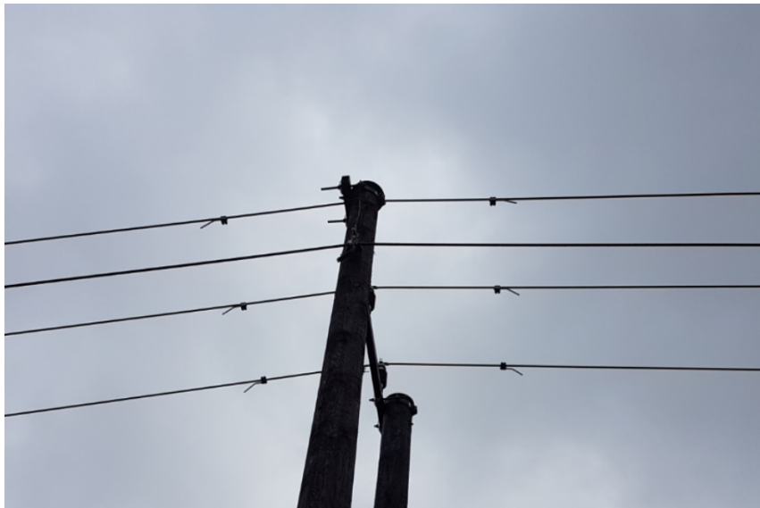
Eksempel på dagens løsning med lynvern tilkoblet lina med isolert penetrerende klemme. Foto: Thomas Skomedal.
