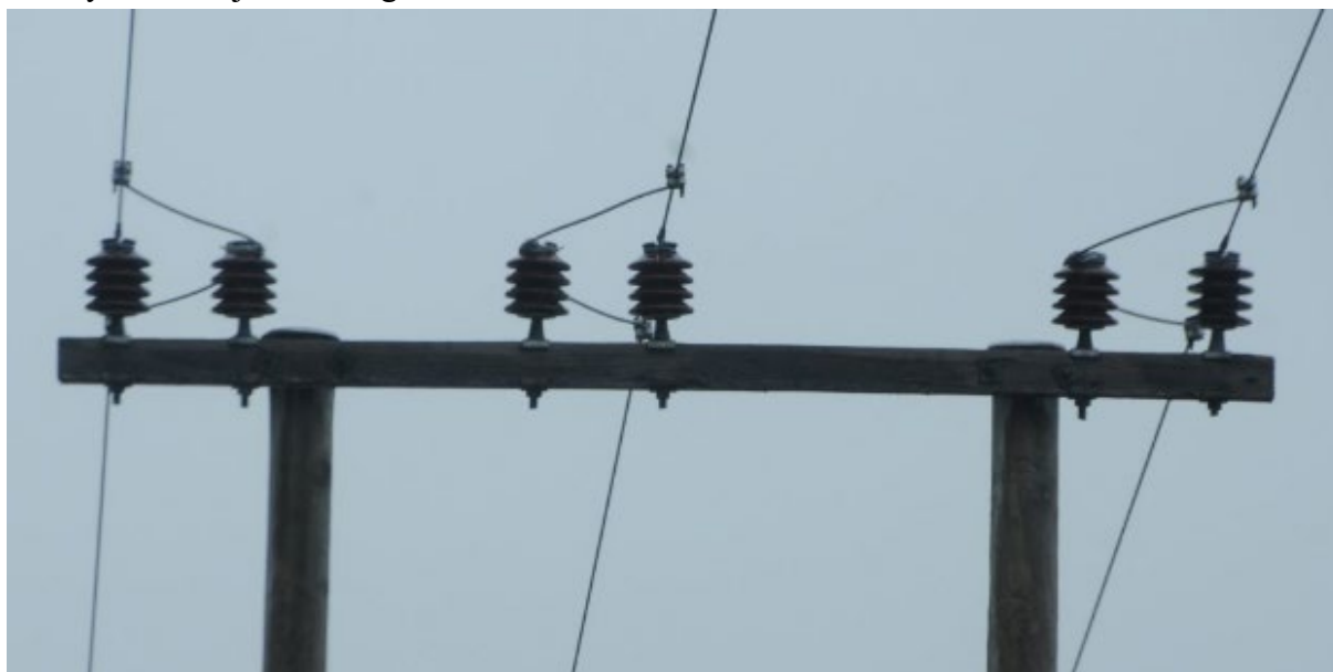
Typisk fareklasse A. Dobbel piggisolator med oppheng. Foto: Jan E. Gunnersen
