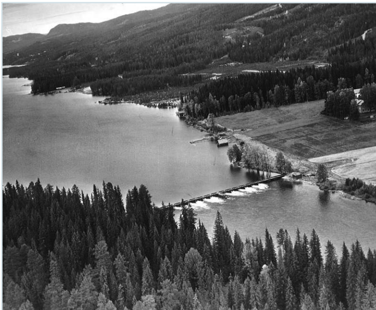
Utløpet av Storsjøen lå ved Løset 4 km lenger opp enn der Storsjødammen ligger i dag, og Søndre Rena var følgende opprinnelig 35 km lang. Foto: Glommens og Laagens Brukseierforening: fotoarkiv.
