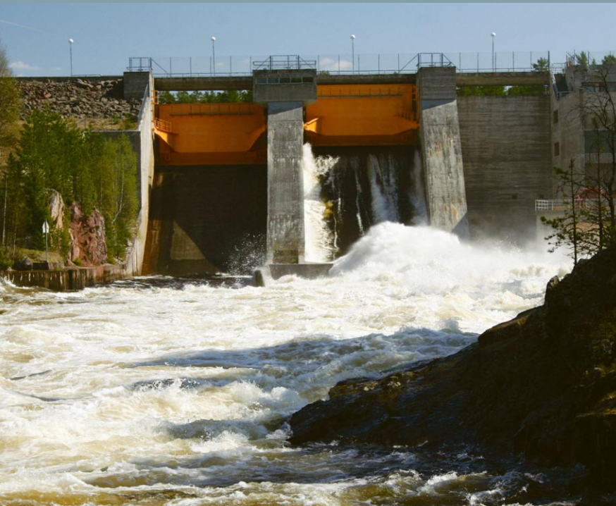
Løpet kraftverk ligger 5,5 km oppstrøms samløpet med Glomma, og 25 km nedstrøms Storsjødammen. Det er et elvekraftverk med en brutto fallhøyde på 19,3 m som kom i drift i 1971. Det er bygget fisketrapp (kulpetrapp) i demningen. Foto: Tore Qvenild.
